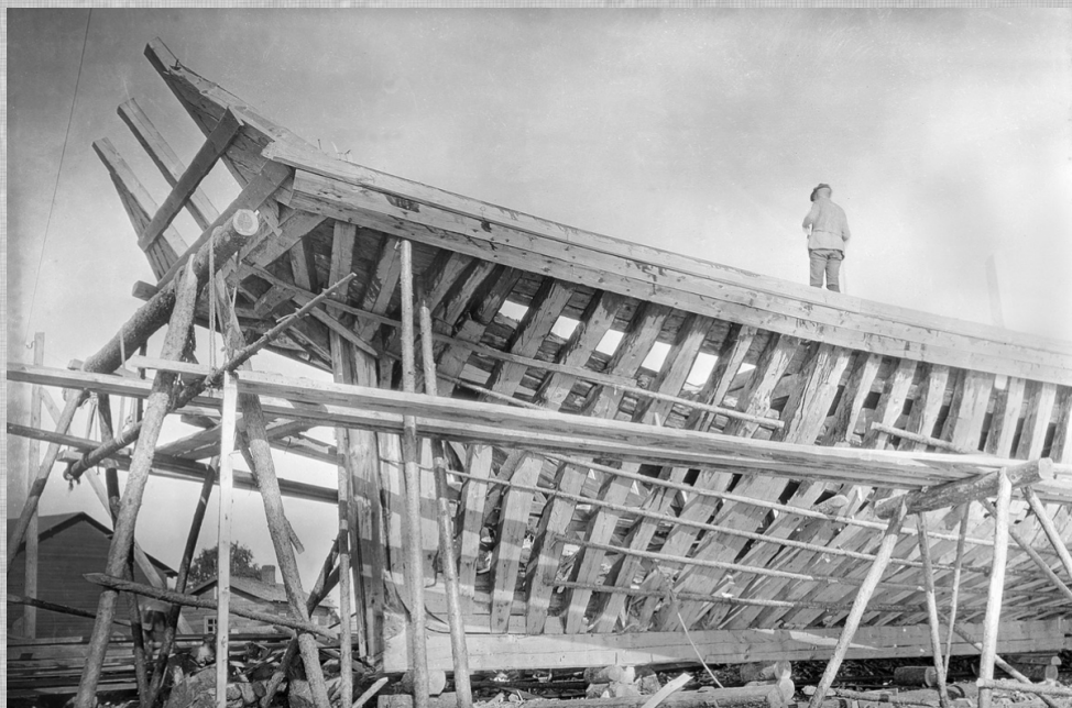
Tekeillä olevan kaljaasin peräpää (Kuvaaja U. T. Sirelius, Kansatieteen kuvakokoelma, Museovirasto)
