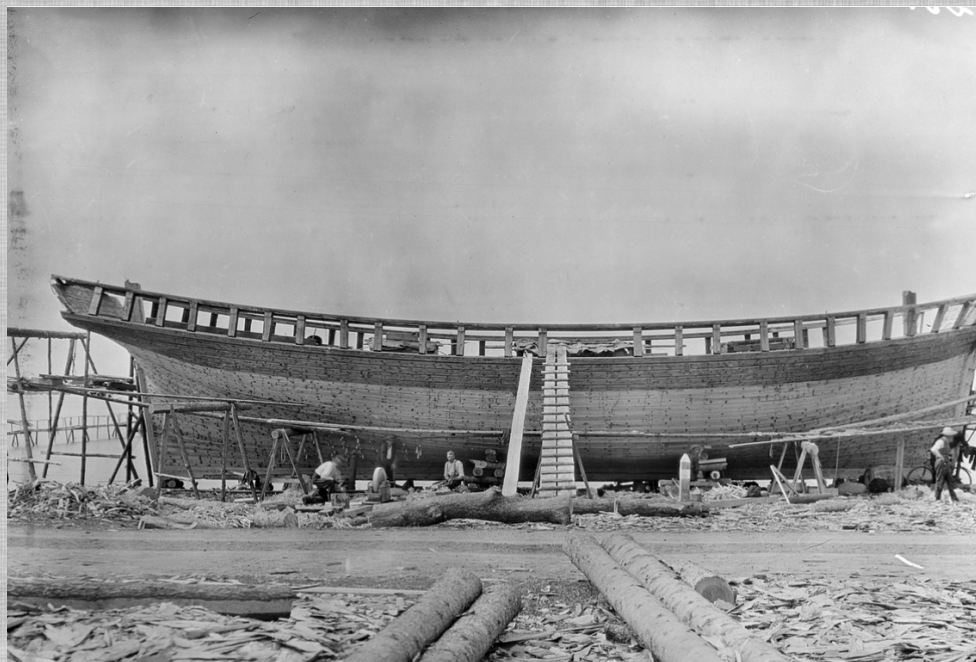
Valmisteilla oleva kaljaasi Koivistolla 1914 (Kuvaaja U. T. Sirelius, Kansatieteen kuvakokoelma, Museovirasto)
