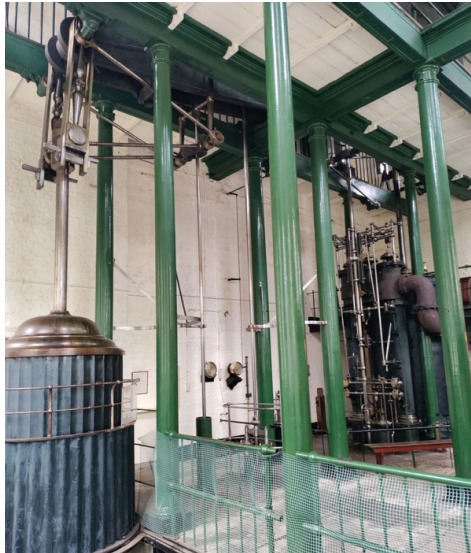
Yleiskuva 90 tuuman pumppukoneesta. Vastapaino ja vesimäntä alhaalla vasemmalla. Kampi ylhäällä. Venttiilistö ja sylinteri oikealla. Pylväät valurautaa.
